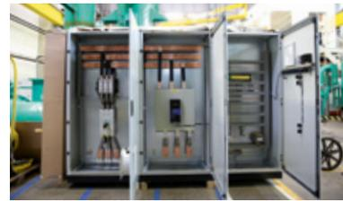
Schaltschrank mit einer Leistung von 580 kW, 1000 A
