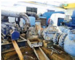
▲ In der Pumpenstation Wala sind Fundamente und Technik sichtlich angegriffen. Undichtigkeiten haben nicht nur einen Wasseraustritt, sondern auch Korrosionsschäden zur Folge. Die Pumpen der Bauarten Splitcase und Ring Section sind in der Vergangenheit teilweise so ausgetauscht worden, dass sich die Leitungsführung in strömungsungünstiger Weise änderte.
