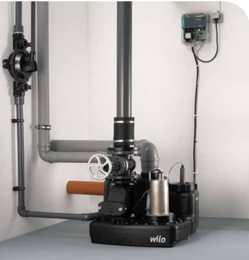
Installationsbeispiel der Wilo-DrainLift M1/8 – mit optionaler Handmembranpumpe.
