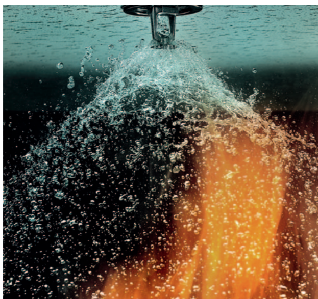
Sprinklersysteem: automatische activering in geval van brand binnen een gebouw voor de effectieve bestrijding van een brand
