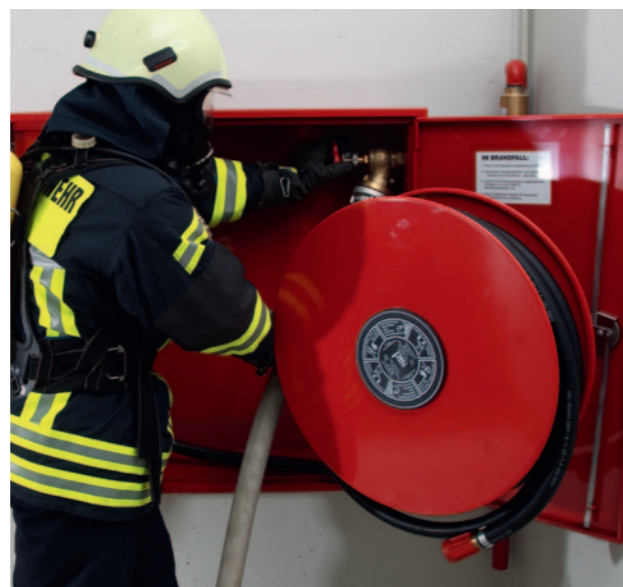
Hydrantsysteem: voor de handmatige, directe bestrijding van een brand binnen een gebouw
