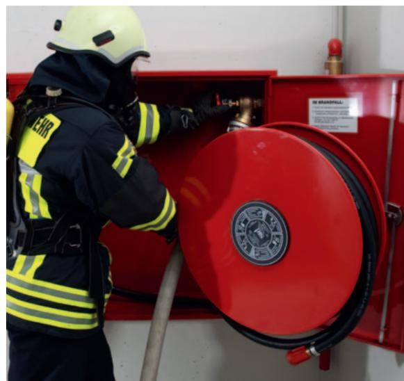
Système de prises d'eau : pour la lutte directe et manuelle d'un incendie à l'intérieur d'un bâtiment
