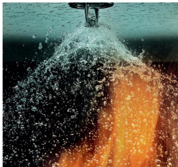
Système « sprinkler » : activation automatique en cas d'incendie survenant à l'intérieur d'un bâtiment pour une lutte efficace contre les flammes
