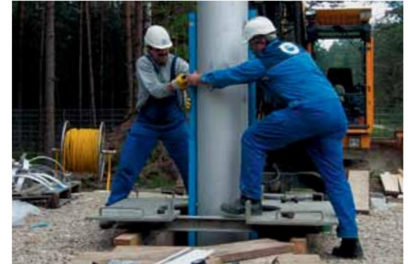
Установка трубы со сплошной стенкой
