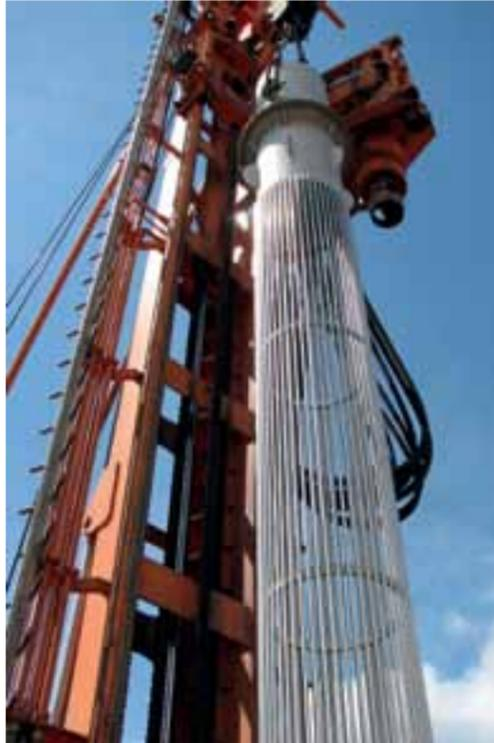
Фильтрующая труба, набранная из стержней
