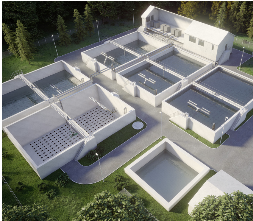
Метод SBR. У кожному SBR-реакторі відбувається перетворення компонентів стічних вод і осаду необхідного для цього активного мулу у циклічній послідовності.
