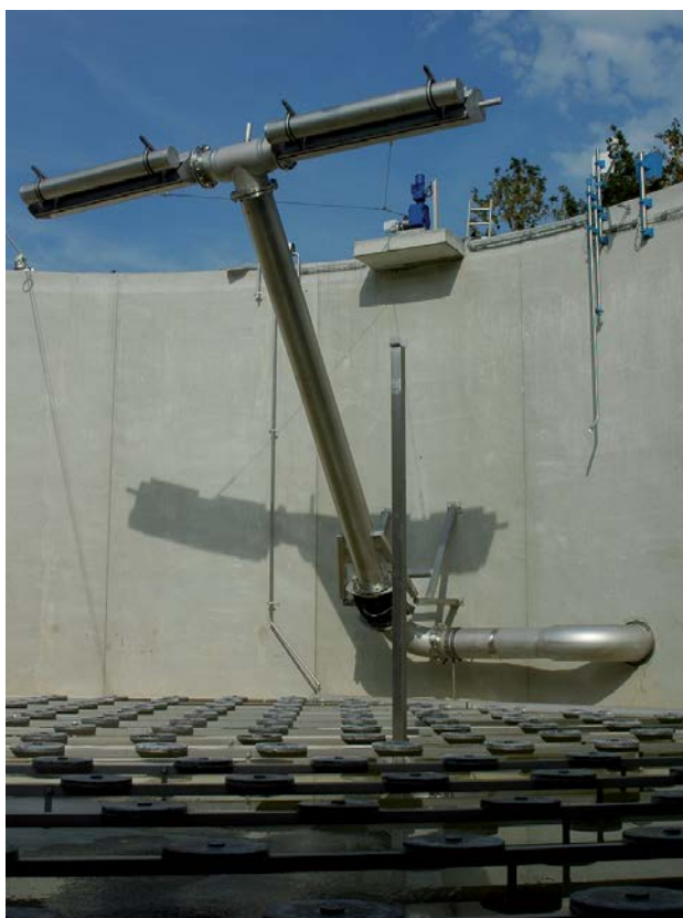
Dekanter w połączeniu z dyfuzorami dyskowymi ELASTOX®-T
