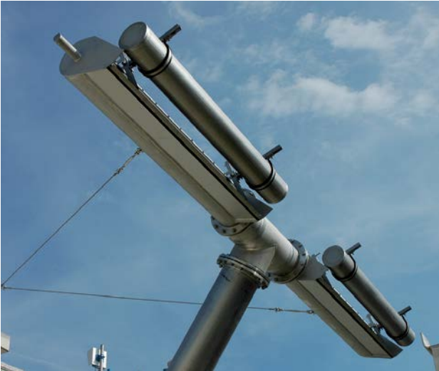
Rura wlotowa czystej wody w dekanterze SBR-DEKA
