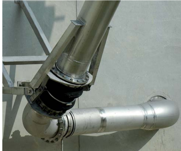
Złącza między rurą odprowadzającą a dekanterem SBR-DEKA
