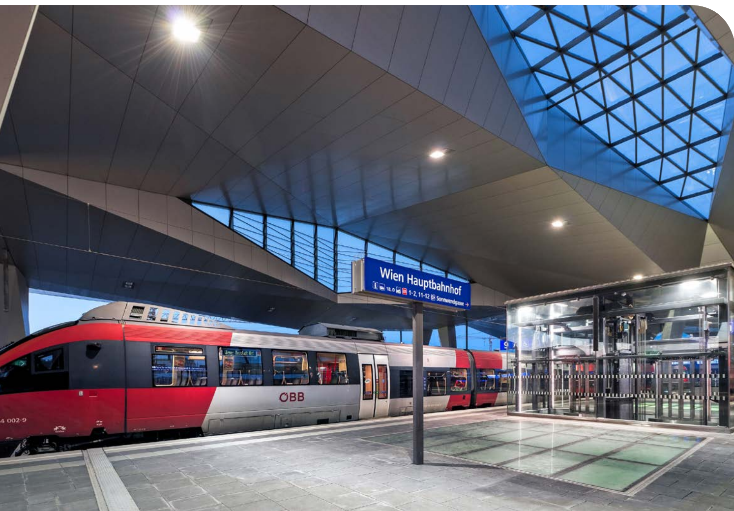
Wiedeński główny dworzec kolejowy. Niezawodne działanie – również dzięki nowoczesnej technologii pompowej do odprowadzania ścieków.
