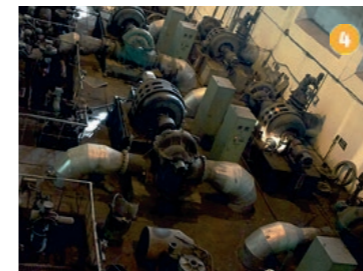
Wassertransport und Kühlwasser, Stahlwerk Bhilai, Chattisgarh, Indien
