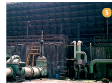
Kühltürme, Ispart, Stahlhersteller/Warmbreitband, Dolvi, Alibaug, Maharashtra, Indien
