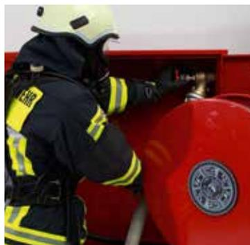
**Wandhydranten:** für die manuelle, direkte Bekämpfung eines Brandes innerhalb eines Gebäudes
