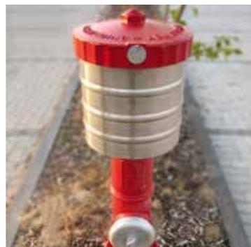
**Außenhydranten:** mit hohen Durchflussmengen für schnelle Zugriffe im Brandfall
