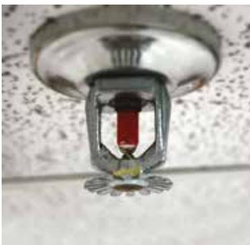
**Sprinklersysteme:** automatische Aktivierung im Brandfall innerhalb eines Gebäudes für die wirksame Bekämpfung eines Feuers
