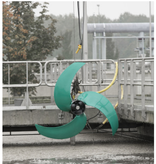
Absenkvorrichtungen für eine optimale Positionierung im Becken
