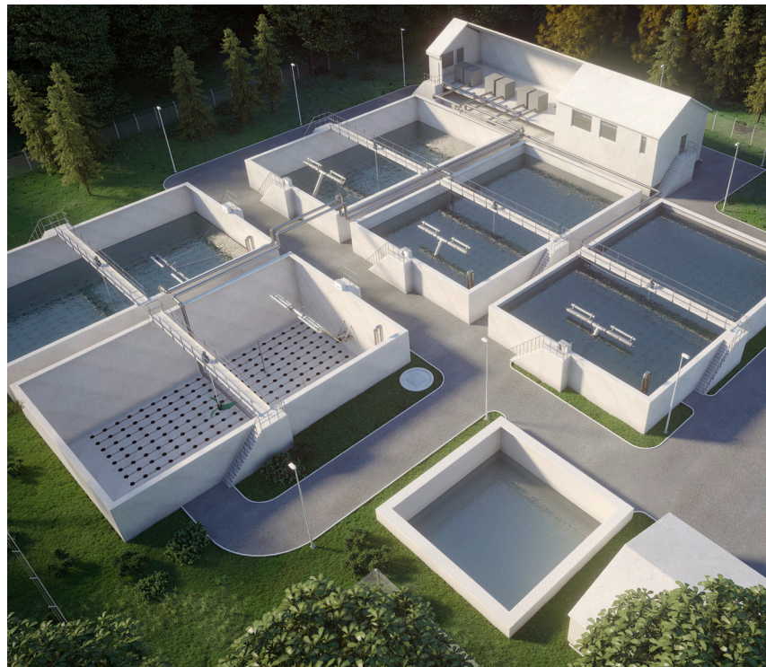
Das SBR-Verfahren auf einen Blick. In jedem SBR-Reaktor erfolgen das Umwandeln der Abwasserinhaltsstoffe und das Sedimentieren des dazu notwendigen Belebtschlammes in zyklischer Reihenfolge.
