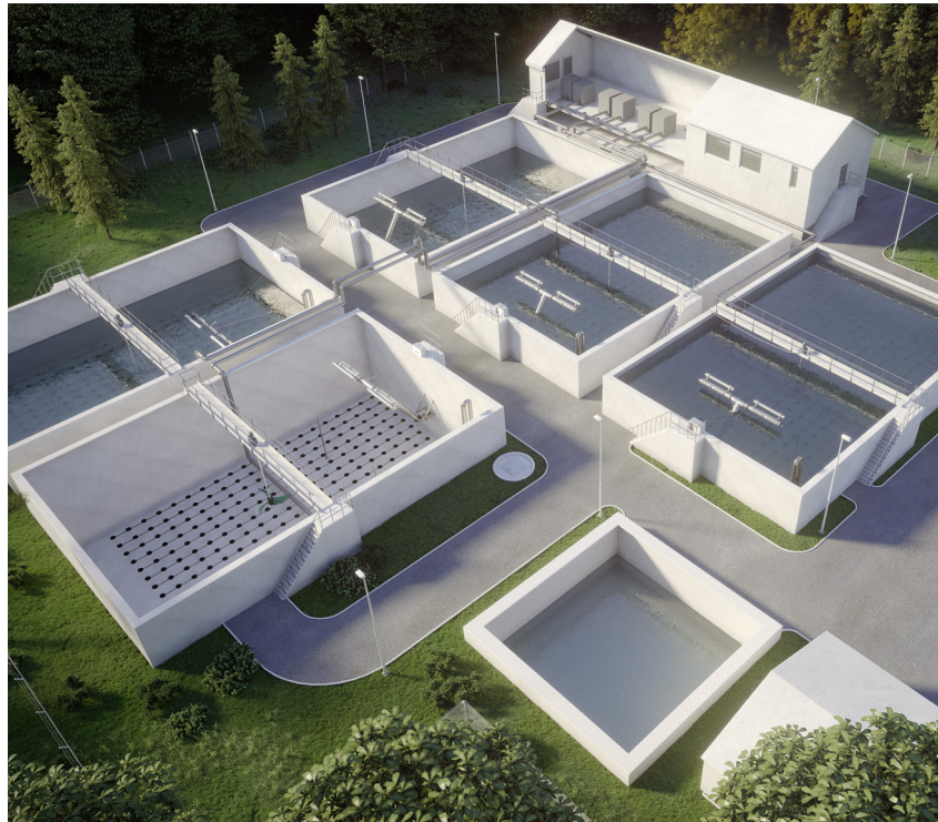
Le procédé SBR en un clin d'œil. Dans chaque réacteur SBR, la transformation des composants contenus dans les eaux chargées et la sédimentation de la boue activée nécessaire à ce procédé s'effectuent de manière cyclique.
