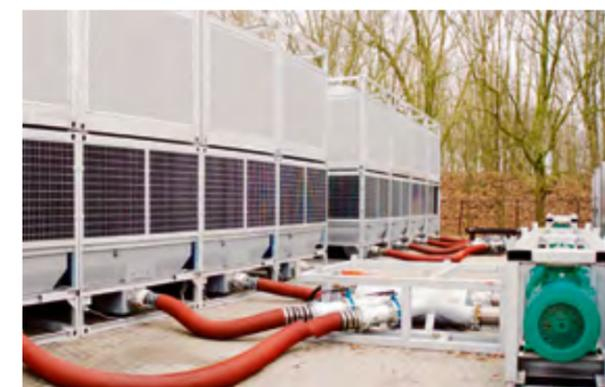
Высокопроизводительная сезонная система промышленного охлаждения может потребовать насосы для работы на открытом воздухе с возможностью демонтажа и складского хранения. Wilo-SCP имеет линейное расположение патрубков, что позволяет создать простую и негромоздкую конструкцию. Болты и фиксирующие элементы из нержавеющей стали, опциональная комплектация моторами со встроенным подогревом позволяет эксплуатировать агрегаты на открытом воздухе.
