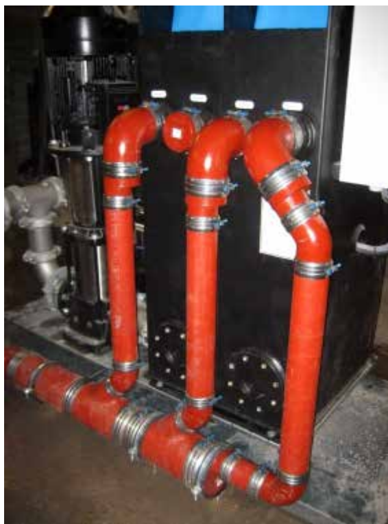
Beispiel einer Anlage mit Volumenstrom von 120 \text{ m}^3/\text{h}
