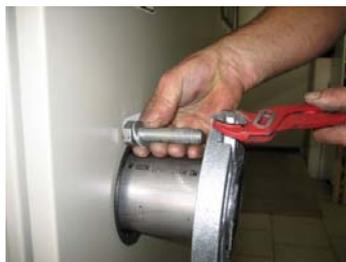
4. Beilagscheibe einlegen (nicht von oben einstecken). Eine Beschädigung der Lippendichtung ist zu vermeiden.
