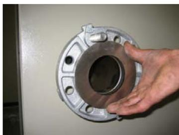
5. Flanschdichtung auflegen und bauseitigen Gegenflansch aufschrauben.
