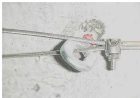
6. Einbringung der Ösenschraube im „trockenen“ Bereich des Zisternendoms (bei Stahl-tanks vorgefertigte Öse verwenden) und Befestigung des Stahlseils an dieser.
