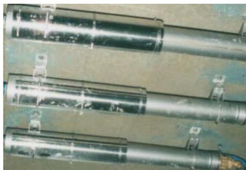
Hydraulische und elektrische Leitungen außerhalb des Erdreiches sind aus nicht brennbarem Material oder in F90 Ummantlung zu verlegen.
