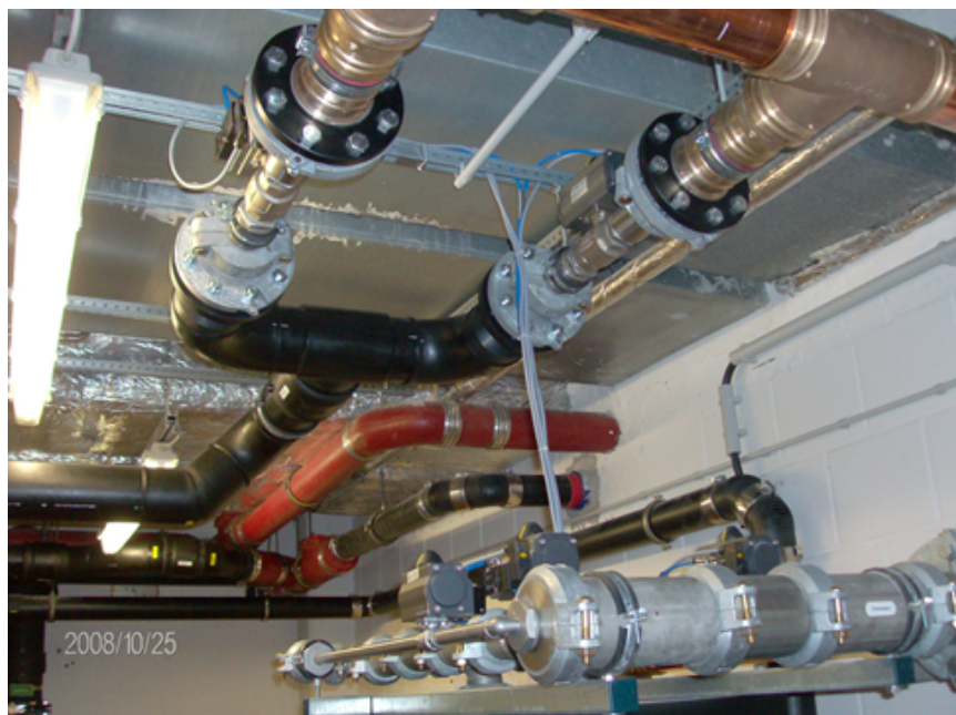
Abbildung 2 Anbindung PNE an Entwässerungsinstallation
