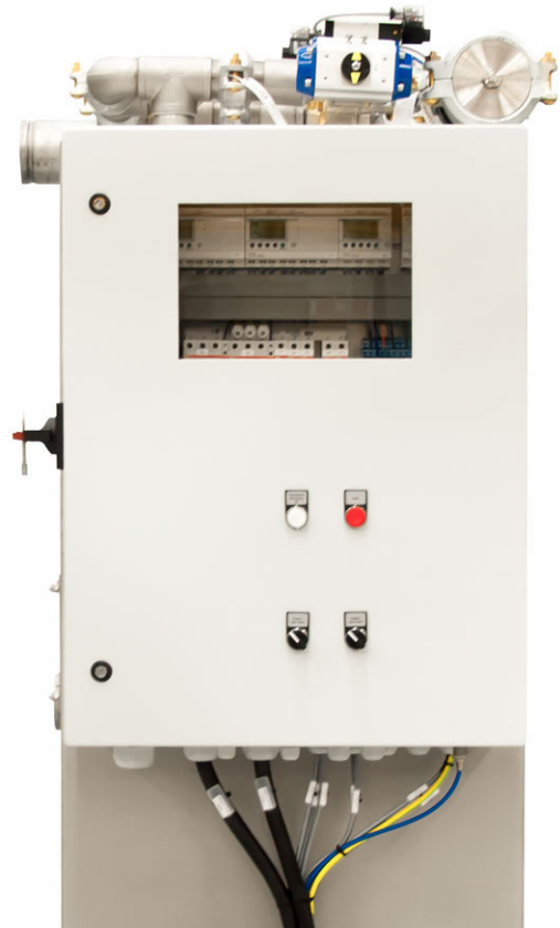
Kabelstrang gebündelt in Reglung
