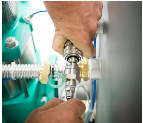
Anschluß Pumpenentlüftungen an Schnellkupplungen Behälter
