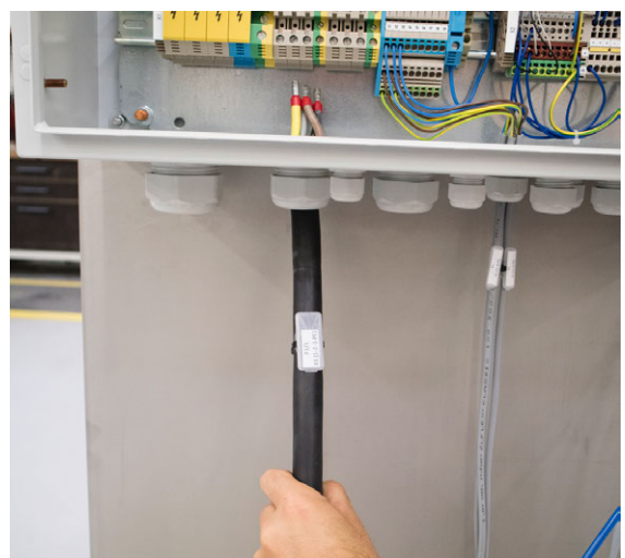
Kabel in Regelung führen
