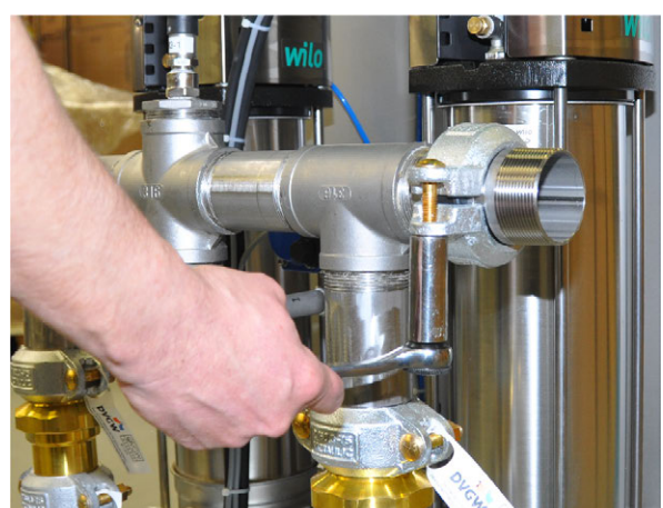
4. Kupplung auflegen und festziehen. Die Nuten der Kupplung greifen in die Rollnutnaht.
