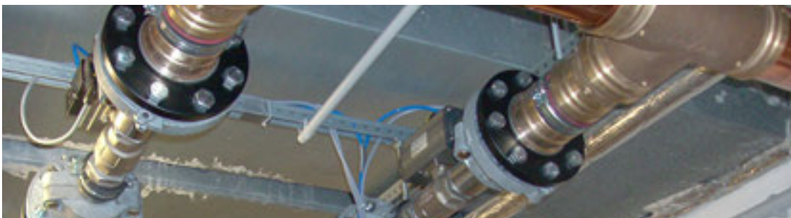
Beispielhafte Anbindung PNE an Entwässerungsinstallation.
