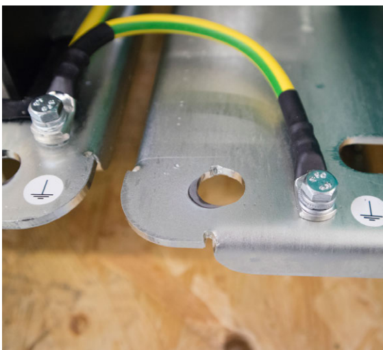
Montierte Erdung
