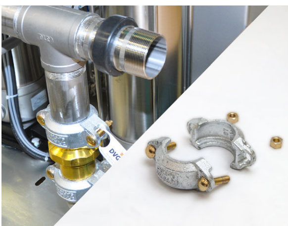
3. Übergangsstück einfügen.
