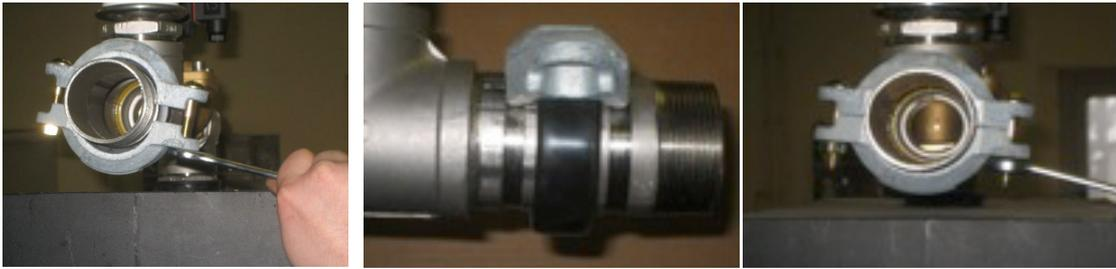
Hinweis: Die augenscheinliche Festigkeit der Verbindung erfolgt erst nach Druckbeaufschlagung, nur bei Einsatz des Übergangsstückes ist die Körperschallentkopplung gewährleistet
