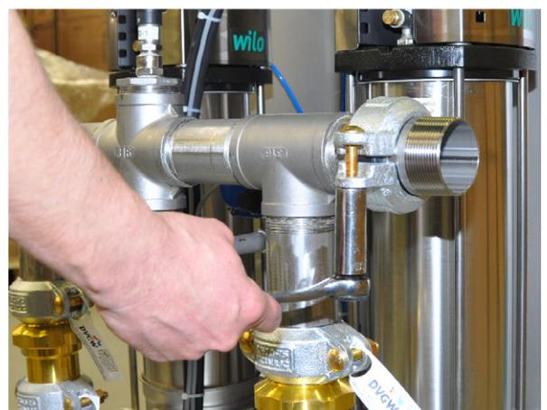
4. Kupplung auflegen und festziehen. Die Nuten der Kupplung greifen in die Rollnutnaht.
