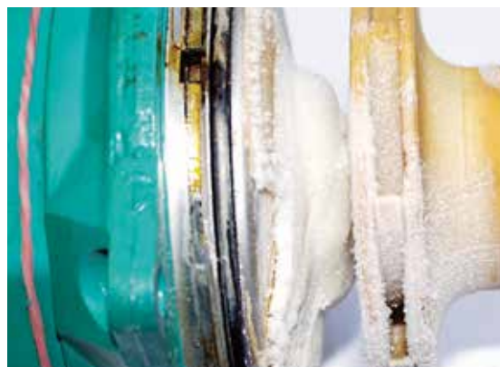
Bild 37: Ablagerungen in einer Pumpe durch falsch gewartete Enthärtungsanlage
