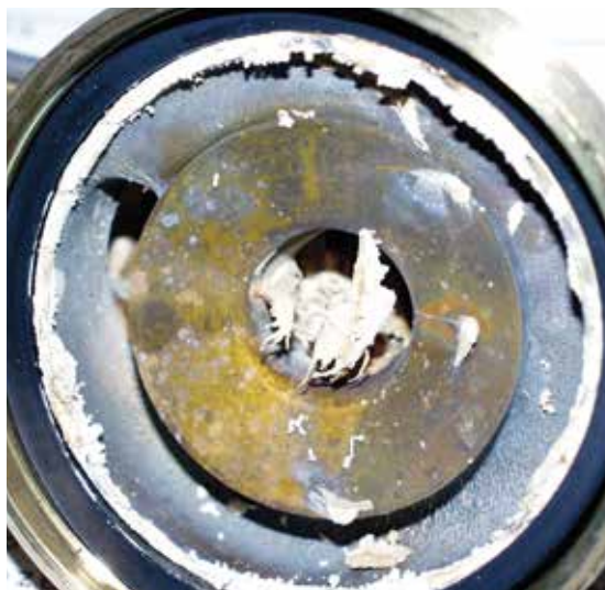
Bild 33: Ablagerungen in einer Zirkulations- pumpe
