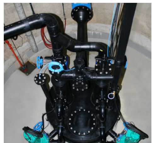
Tłocznia PEHD w studzience betonowej
