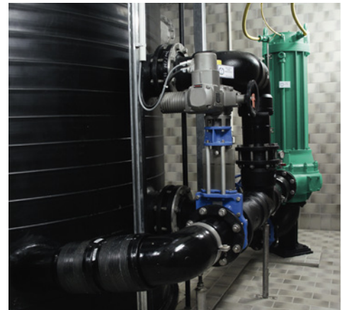
Widok zbiornika tłoczni z PEHD i jednej pompy
