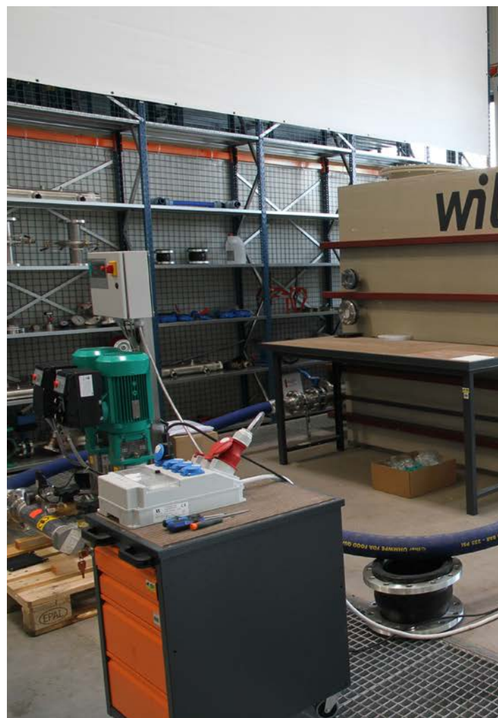
Stacja prób pomp do wody czystej w siedzibie Wilo Polska w Lesznowoli.
