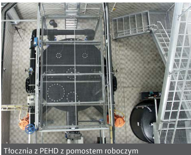
Widok zbiornika tłoczni z PEHD i jednej pompy
