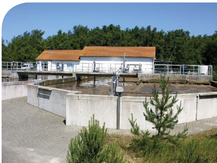
Zakład oczyszczania ścieków Hiddensee
