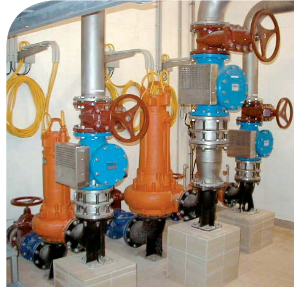
Pompy i armatura wyposażone w układ sterowania
