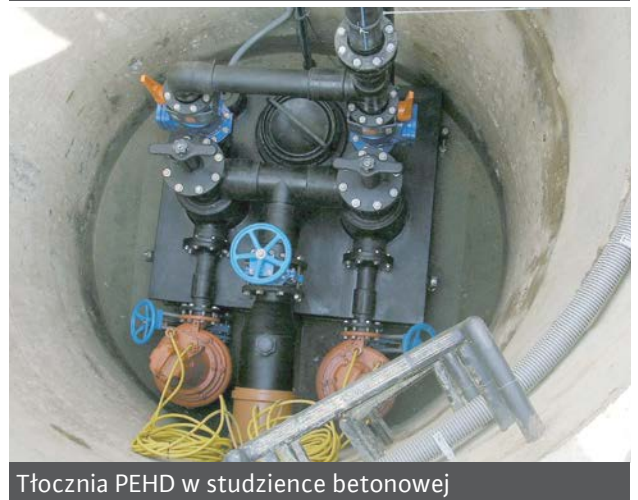
Tłocznia z PEHD (komora zewnętrzna podziemna również z PEHD) ze schodami zabiegowymi
