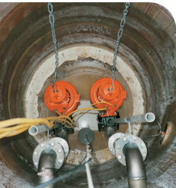
Przepompownia z pompami zainstalowanymi w mokrej studzience
