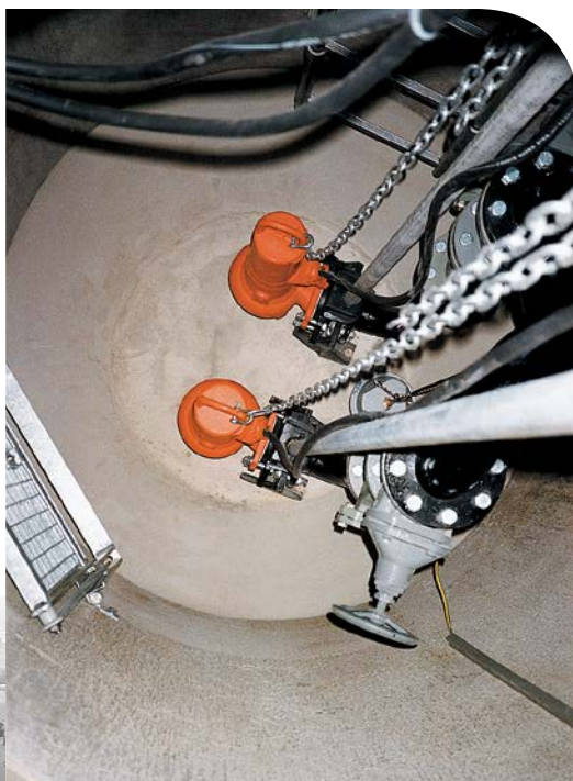
Przepompownia – prowadnice rurowe ze stali nierdzewnej i łańcuchy do podnoszenia
