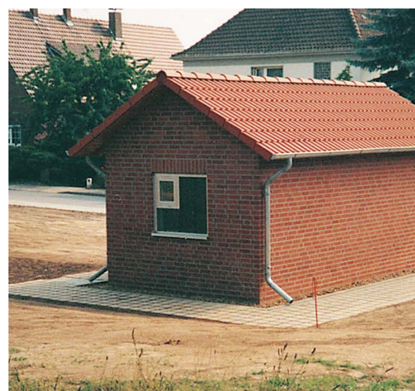
Budynek pomocniczy obudowany cegłą z dachem spadzistym
