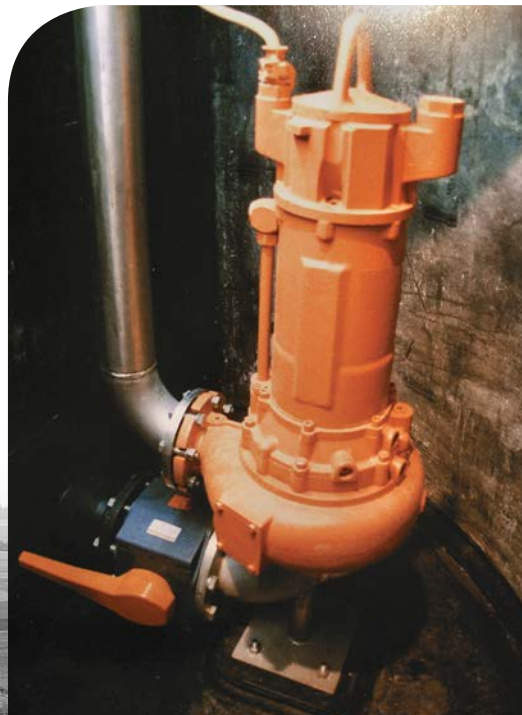
Pompy z wewnętrznym zamkniętym chłodzeniem olejowym
