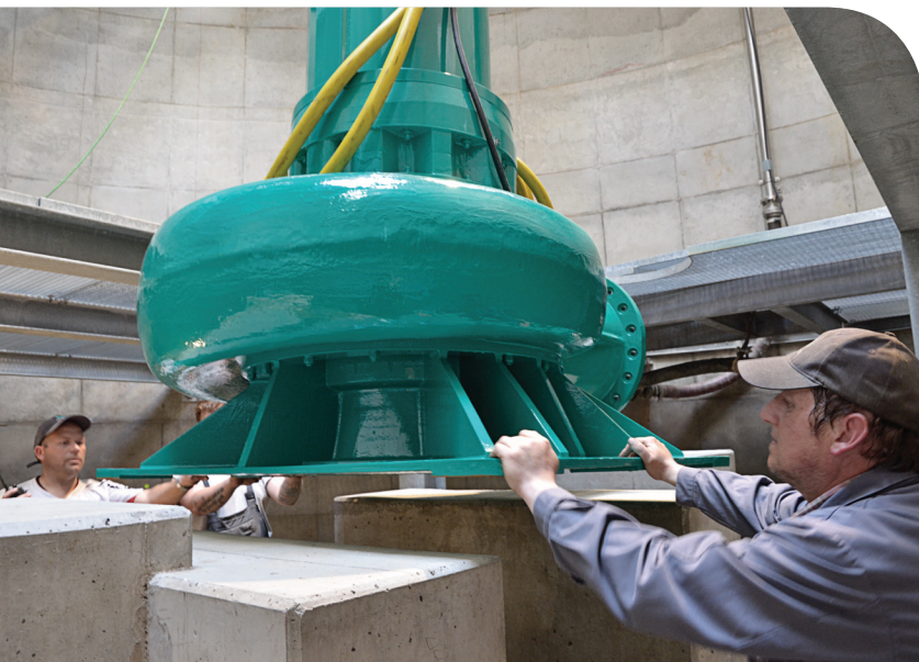
Die Wilo-EMU FA: Bestens geeignet zur Nass- und Trockenaufstellung
